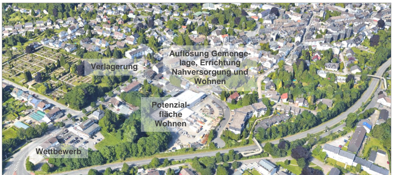
Abbildung 50: Luftbildaufnahme Lupenraum West
