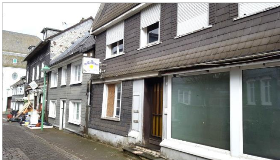
- vernachlässigte Gebäude / Fassaden verschlechtern das Straßenbild
